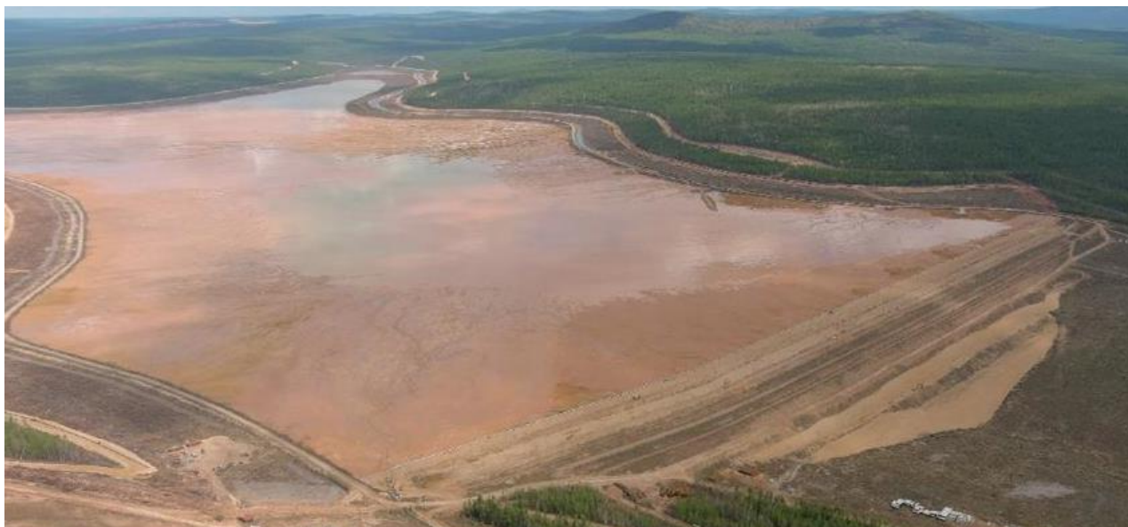
Рисунок 5 – Ложе хвостохранилища с надводным пляжем
