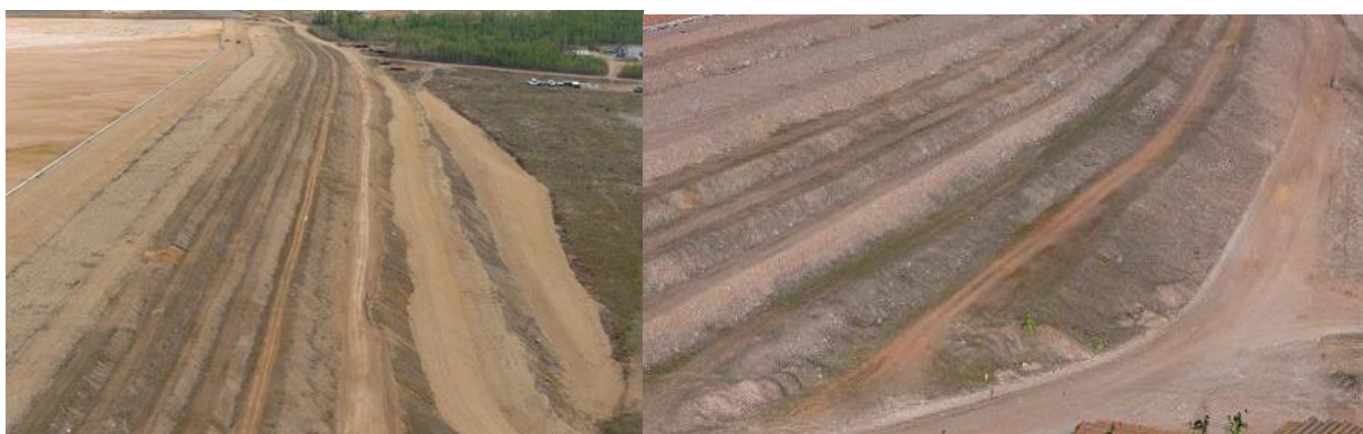
Рисунок 2 – Вид на низовой откос и гребень дамбы хвостохранилища
